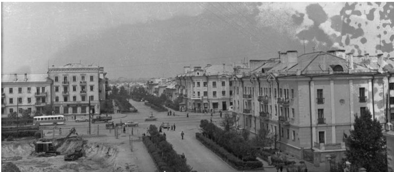
Угол ул. Алалыкина и Ленина. Строится корпус мединститута
